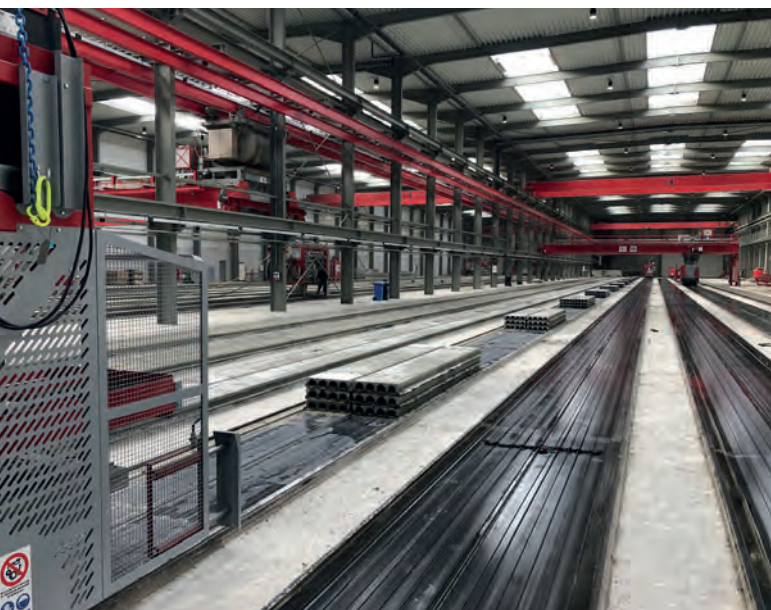
Штабели из пустотных плит вдоль производственных дорожек
