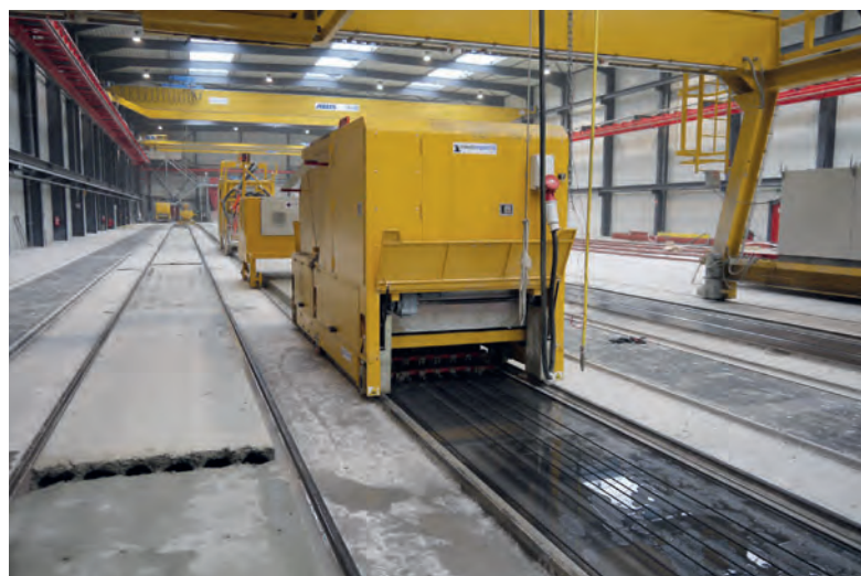
Экструдер во время бетонирования пустотных плит на заводе в Малле
